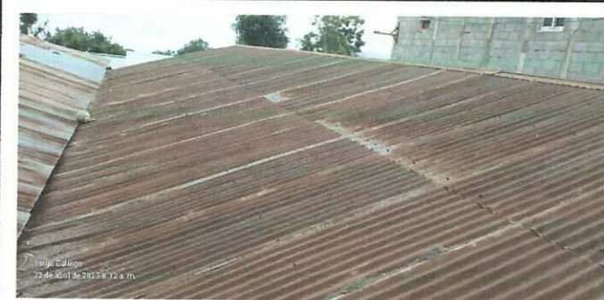
CUBIERTO DE LAMINAS: Sustitución de lámina existente por lámina troquelada. -Cambio de techado con lámina troquelada de 2 aulas con medidas 18 mts de largo por 5.80 mts de ancho
