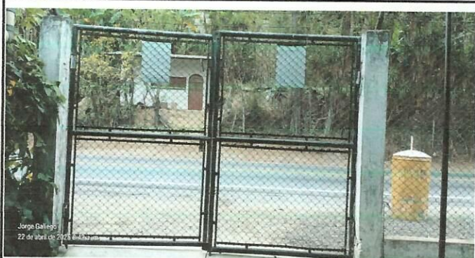
PUERTAS DE METAL: Sustitución de Portón actual y Fabricación portón alterno. -Sustitución de Portón actual con medidas 2.98 mts Ancho por 2 mts altura -Fabricación de Portón con Malla alterno para entrada de vehículos con medidas 3 mts de ancho por 2.50 mts de altura
