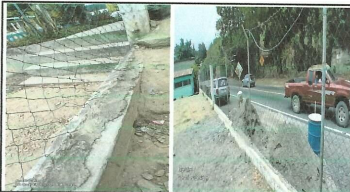
REPARACIÓN DE MURO PERIMETRAL: Cambio de malla actual al muro perimetral. -Cambio de malla muro perimetral con medidas de 52 mts lineales por 2 mts de alto
